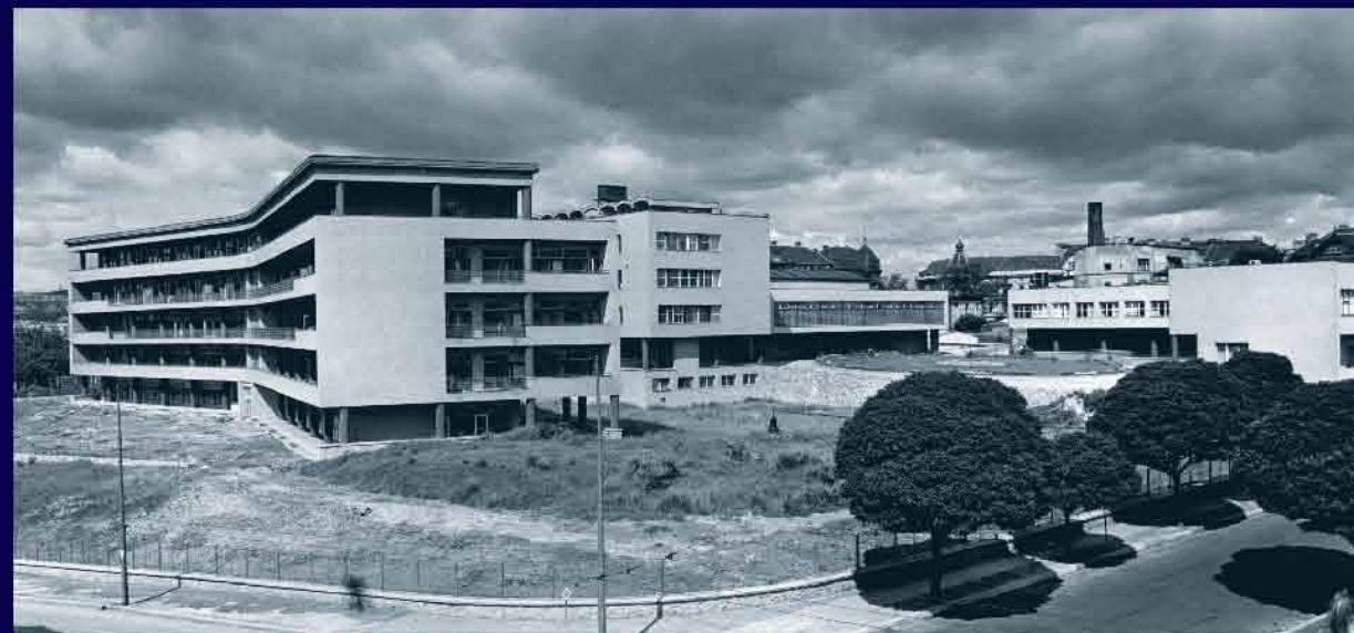
Dětská nemocnice v Brně
